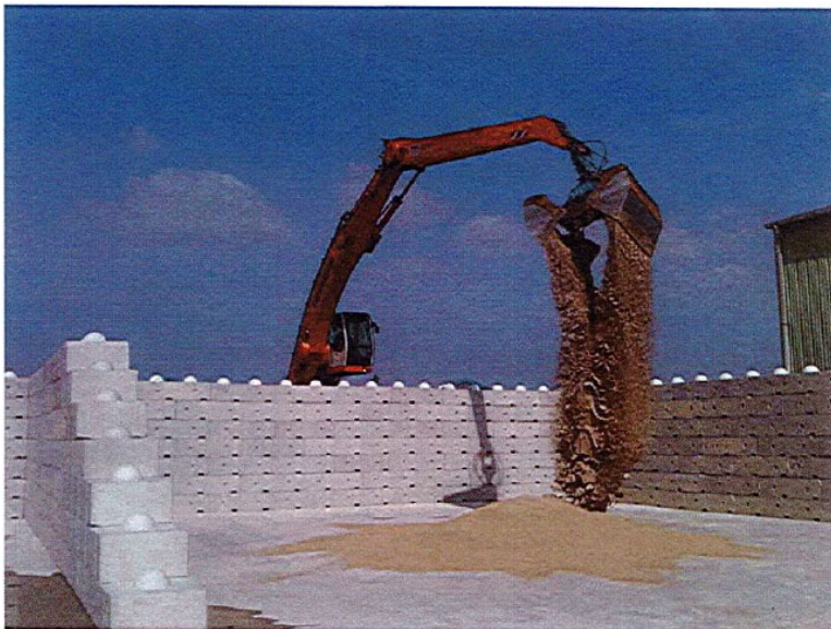
Figure 2 : Vue de BOPLO formant des murs poids permettant la délimitation d'espaces de stockage.
