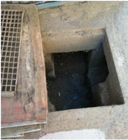
◀ Figure 13 : Vue du collecteur d'eaux pluviales présent sur site.
