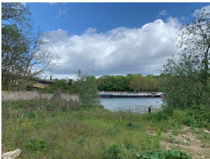
Figure 45 : Crête de berge au niveau de l’implantation de la zone d’implantation de l’ouvrage projeté.
