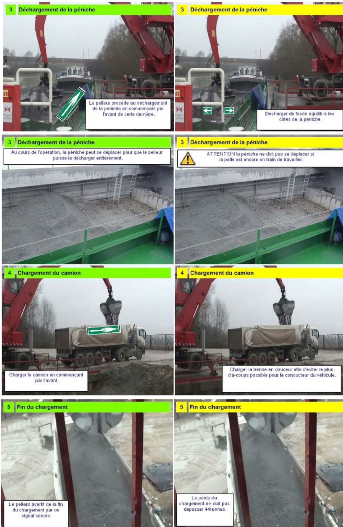
Figure 54 : Mode opératoire de déchargement de la péniche.
