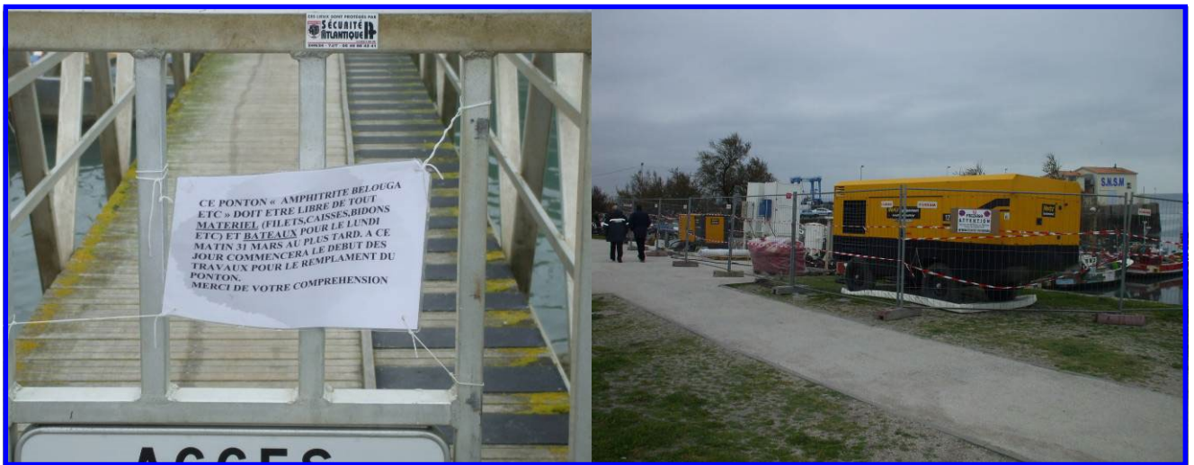
Figure 51 : Exemples d'information et de limitation de la zone relative au chantier.
